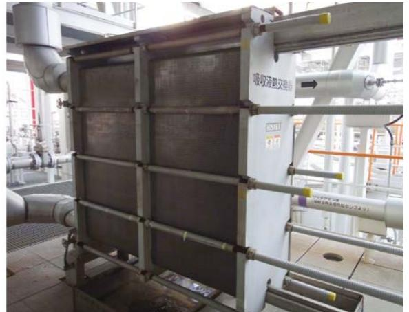
CO<sub>2</sub>回収プロセスで使われるアミン溶液の
