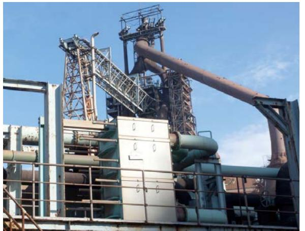
製鉄プラントの高炉冷却水の冷却
