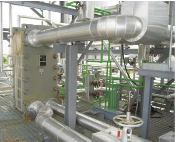
排熱回収によるボイラ給水加熱
