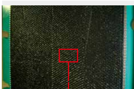
↑ 熱交換器 海水入口通路孔 ゴミ、藻、貝類で流路が閉塞し、流動障害を生じている。
