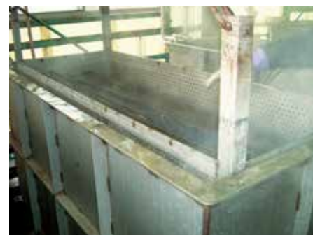
↑ 開放したプレートを薬液槽に浸漬して強固なスケールを除去します。
